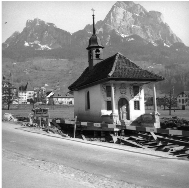
Bild: Kantonale Denkmalpflege Schwyz
