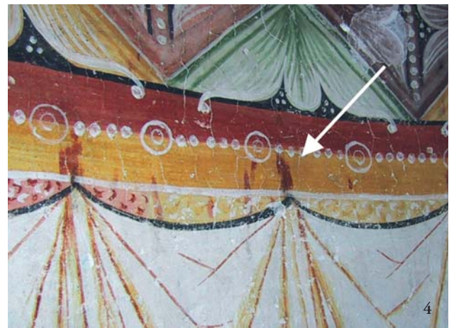
Abbildung 4: In einer der Apsiden in der Klosterkirche von Müstair (Schweiz) hat sich die gelbe Farbe (Ocker?) dort zu Rot verändert, wo früher einmal Kerzenflammen in der Nähe waren (Pfeil). Solche Farbveränderungen sind recht häufig an Wandmalereien zu beobachten.
